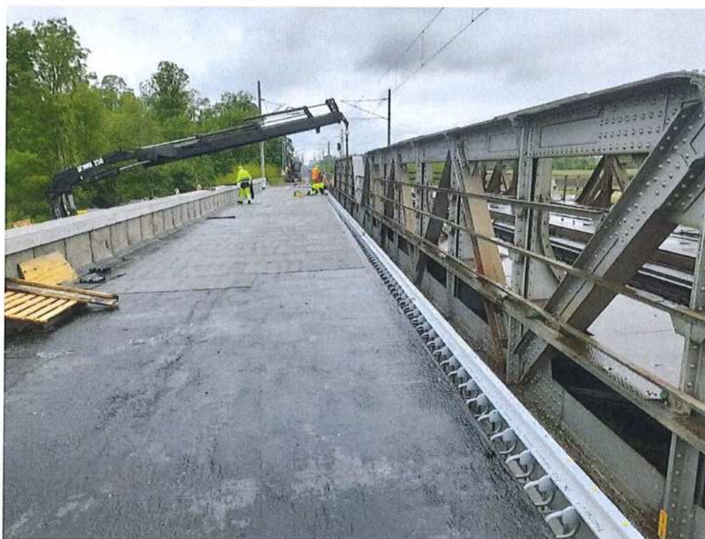
Izolácia mostovky a montáž pozdĺžnej dilatácie – SO 12-33-02
