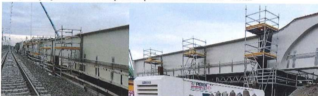
c) Chýbajúce označenie bezpečného používania komunikácií – lešení
