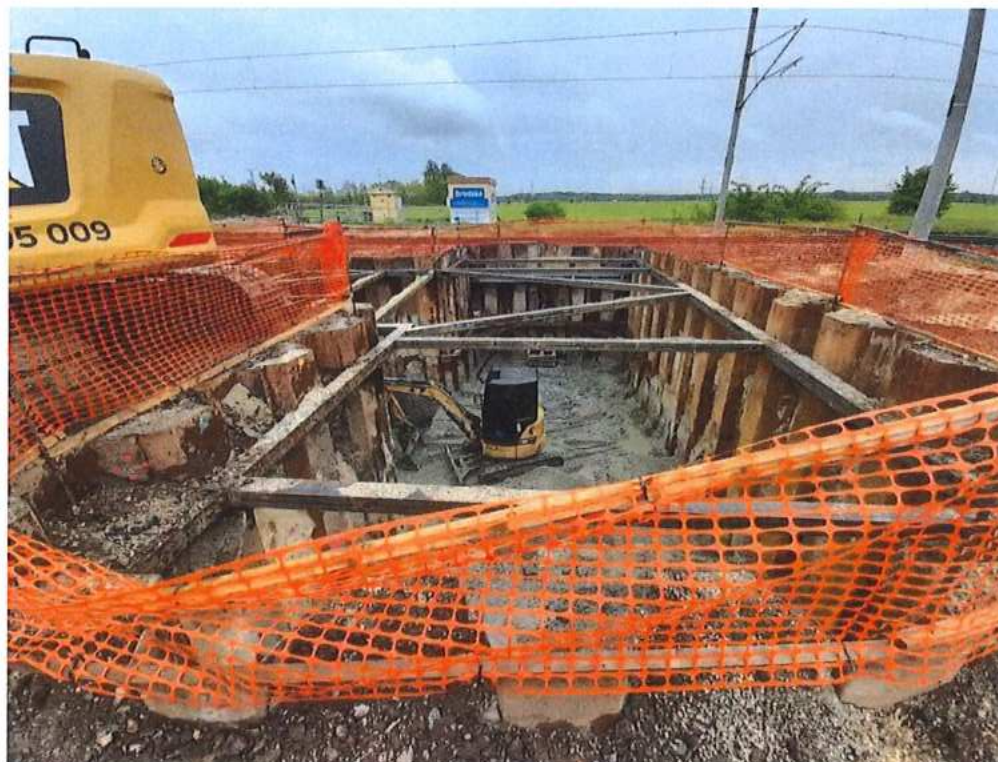
Zemné práce v zaistenom výkope v TK 1 na úroveň zákl. škáry – SO 11-33-01
