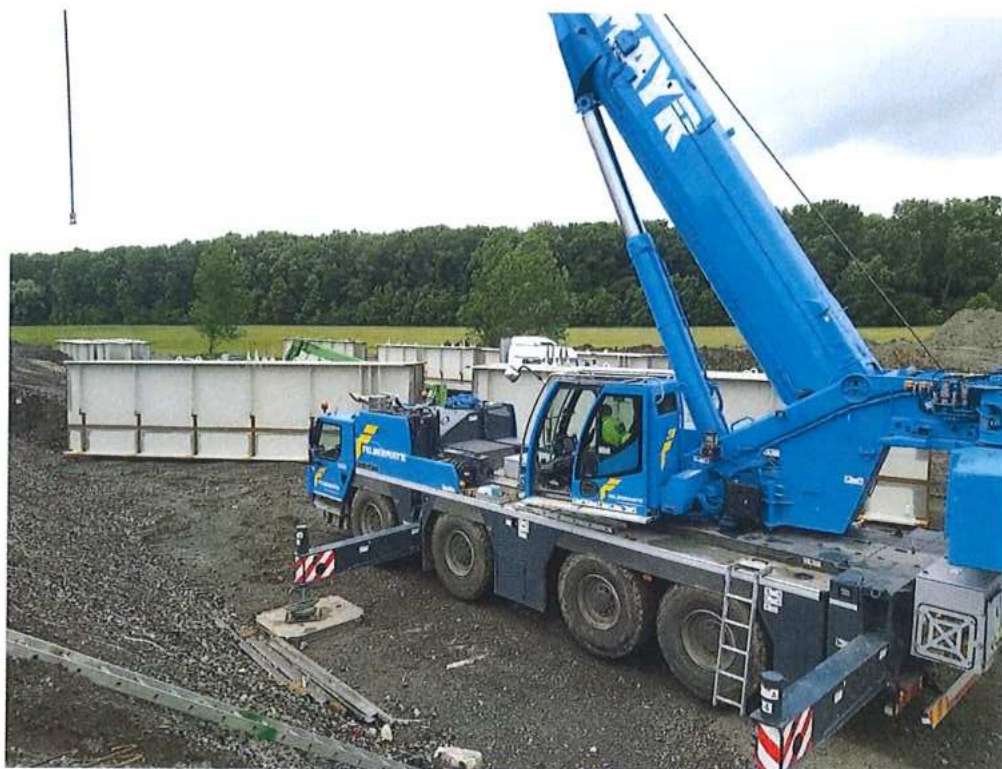
Dovoz nosníkov oc.konstruktie mosta cez rieku Morava – SO 12-33-04
