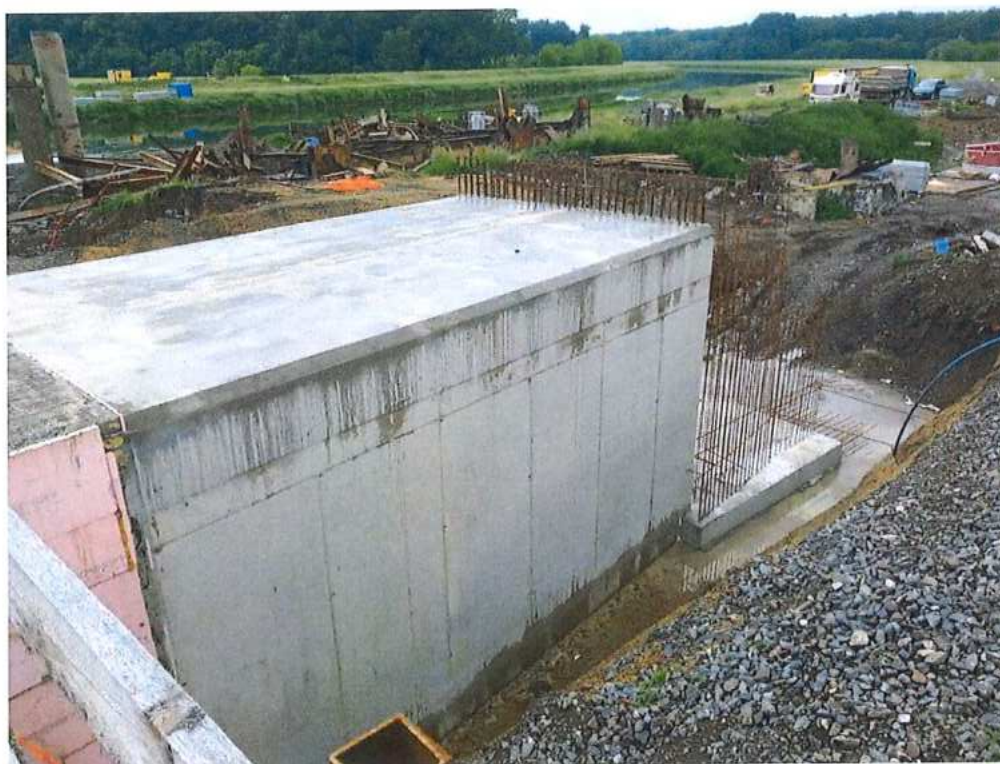
Oddebnenie stropnej dosky a zahájenie armovania krídiel – SO 12-33-05
