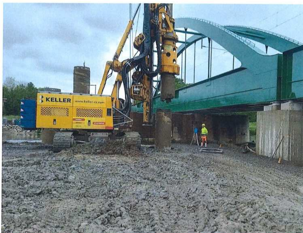
Realizácia pilót na SK strane - základ č.1 – SO 12-33-04
