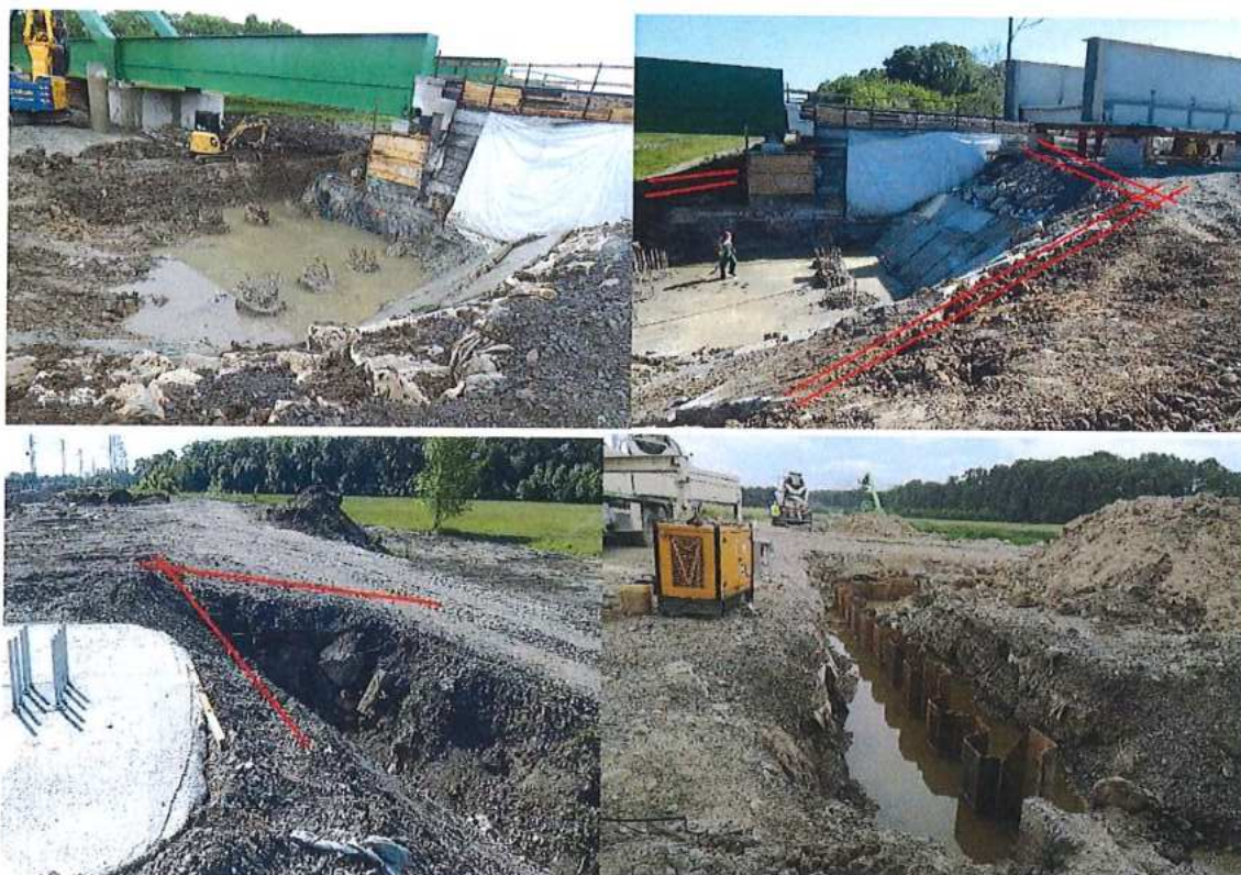
c) Chýbajúce označenie bezpečného používania komunikácií – lešení
