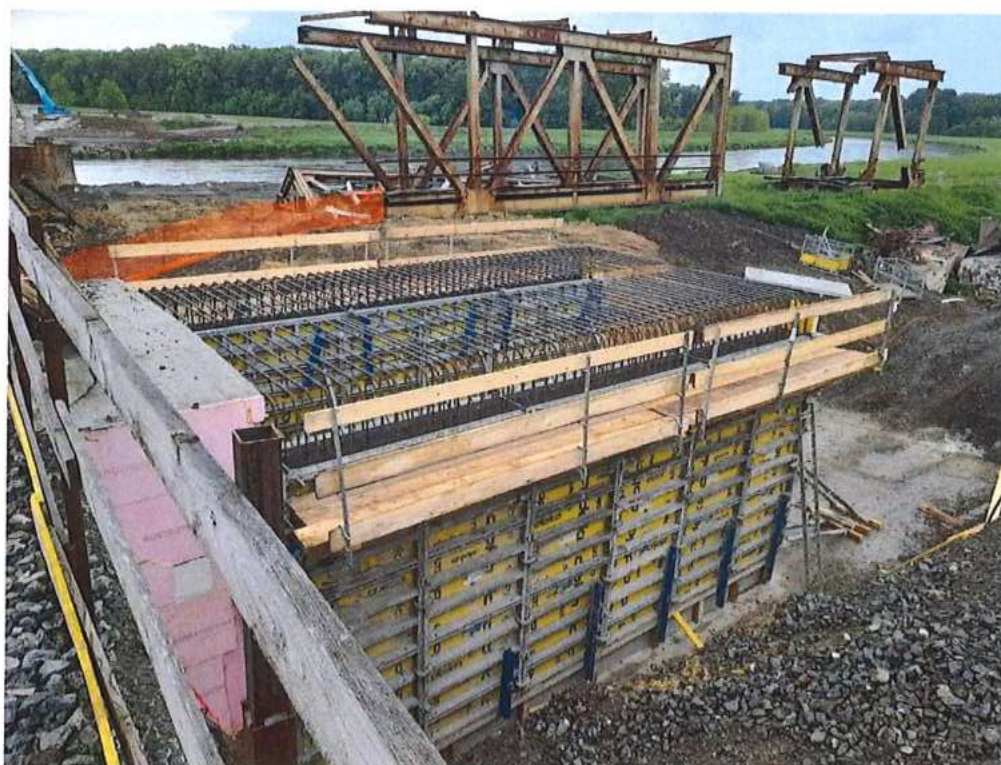
Armovanie a debnenie stien – SO 12-33-05
