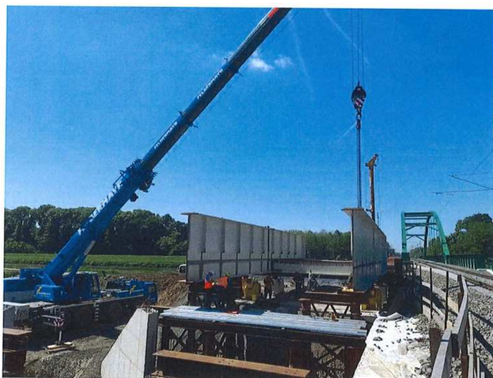
Montáž nosníkov oc.konstrukcie mosta cez rieku Morava – SO 12-33-04
