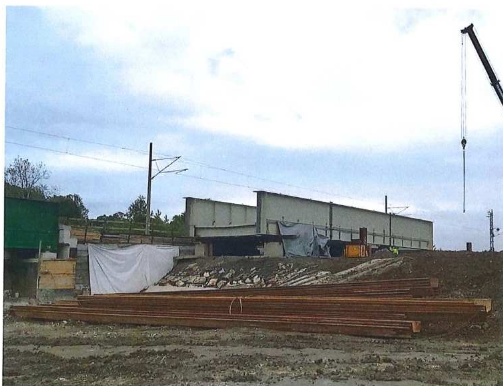
Montáž nosníkov oc.konstruktie mosta cez rieku Morava – SO 12-33-04
