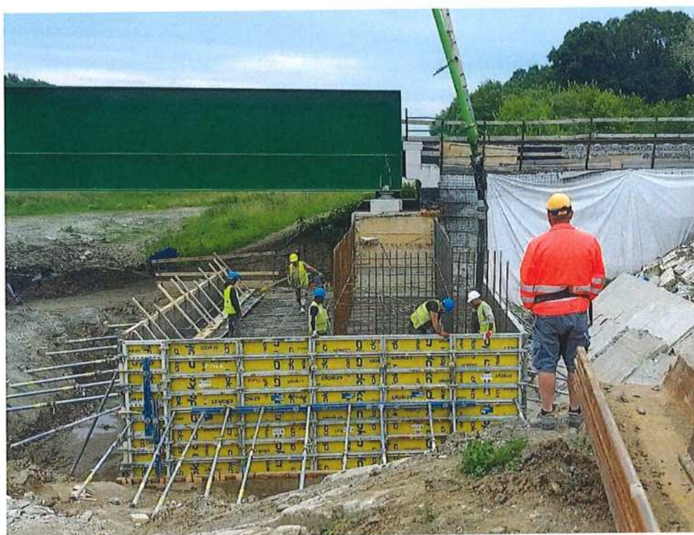
Betonáž základu - opora č.1 – SO 12-33-04
