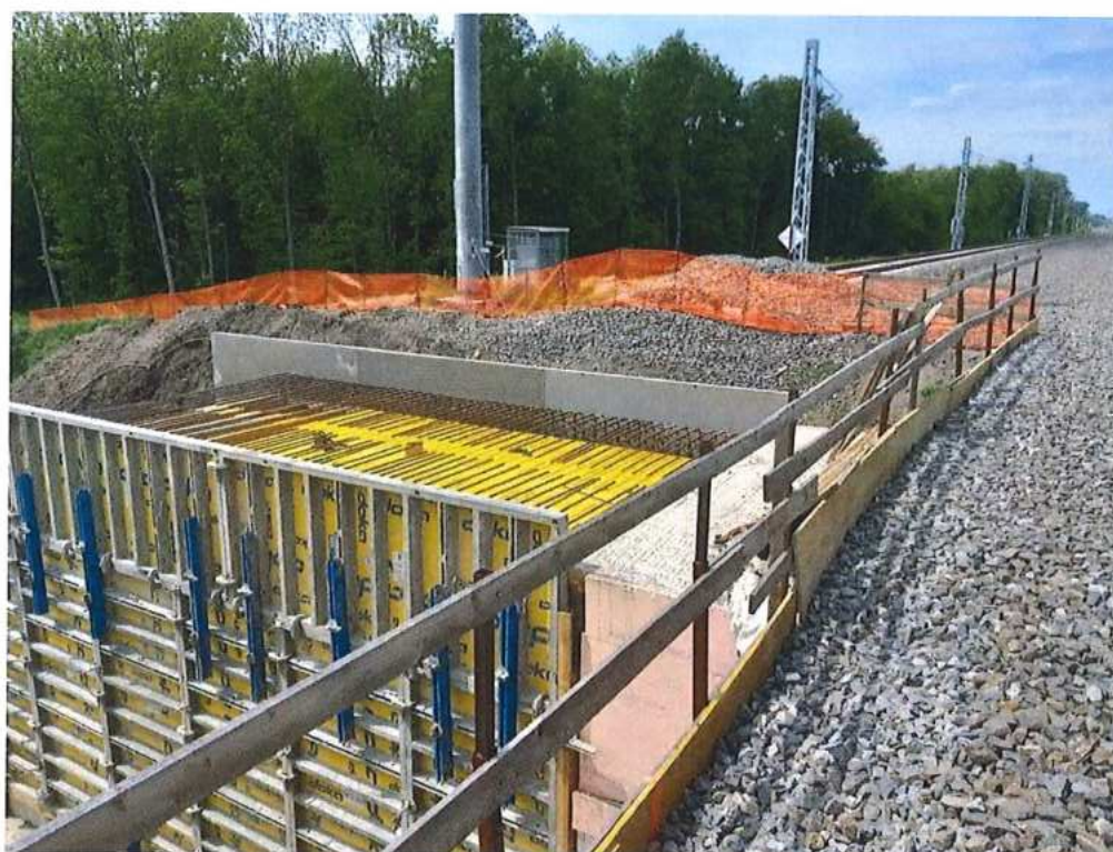
Armovanie a debnenie stropnej dosky – SO 12-33-05
