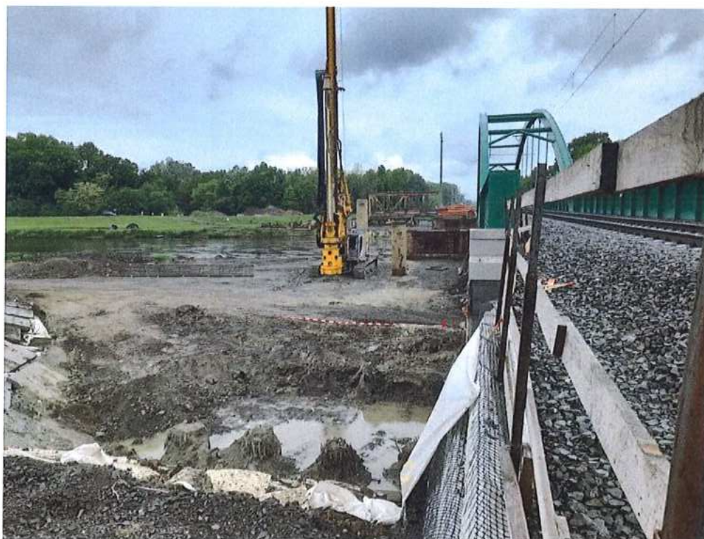
Realizácia pilót na SK strane - základ č.1 a odkop pilót na opore č.1 – SO 12-33-04
