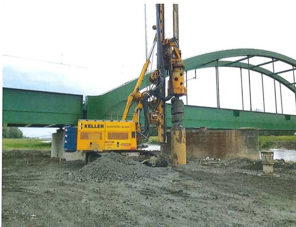
Realizácia pilót na CZ strane - základ č.2 – SO 12-33-04
