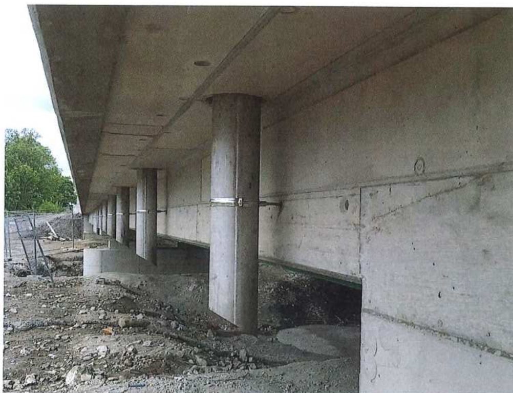
Montáž odvodňovačov – SO 12-33-02
