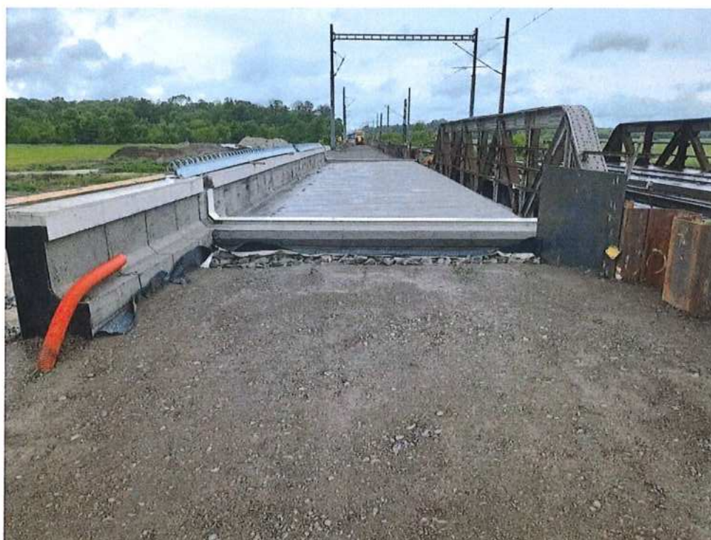
Realizácia prechodovej oblasti pri opore č. 1 – SO 12-33-01
