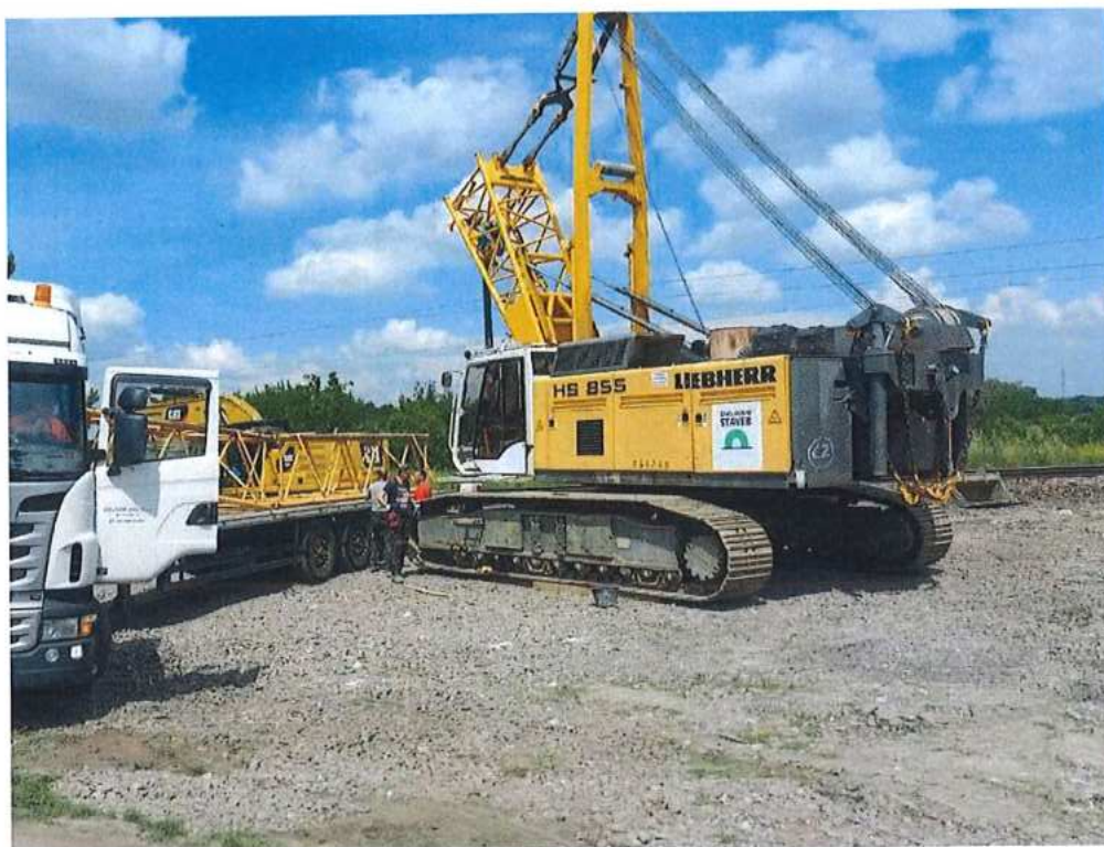
Dovoz technológie na realizáciu podzemných stien – SO 11-33-04
