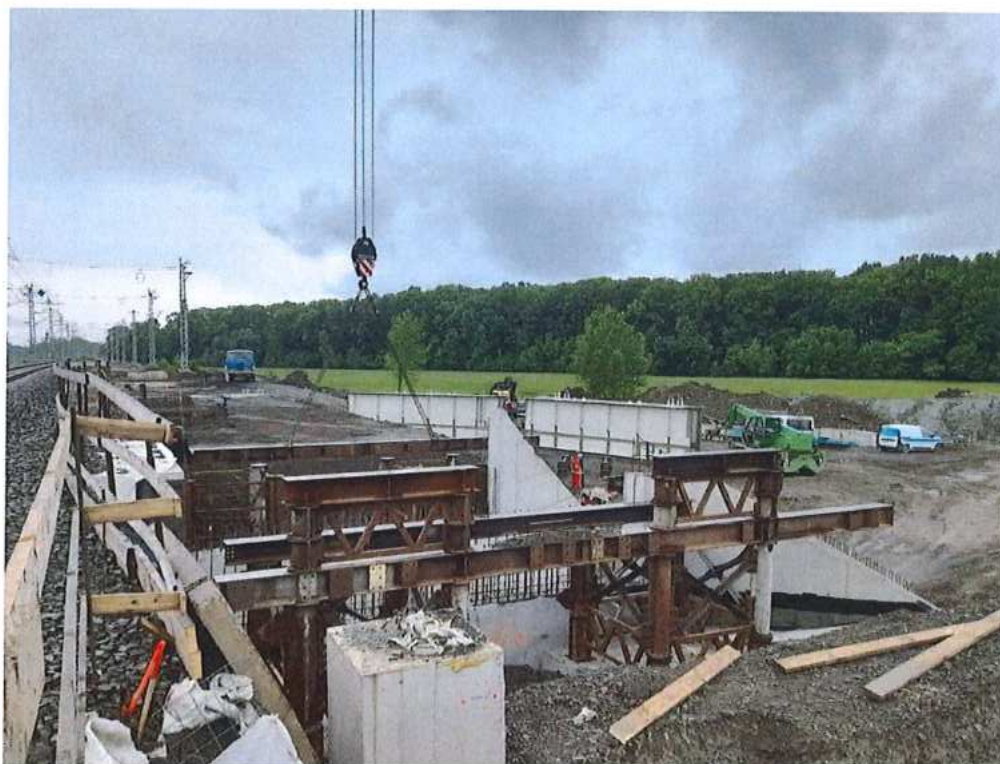
Príprava podpornej konštrukcie výsuvnej dráhy – SO 12-33-04
